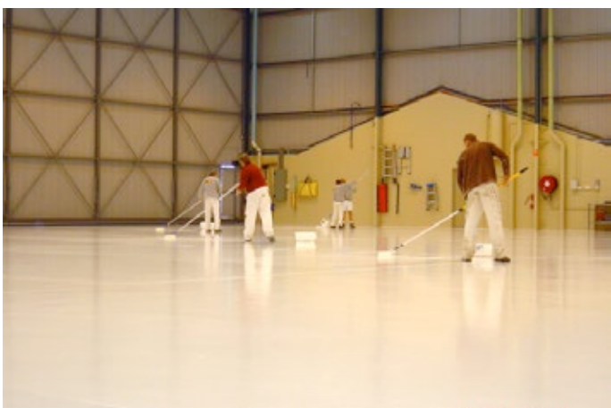
Objekt: Hangar Flughafen Perth Untergrund: Beton
