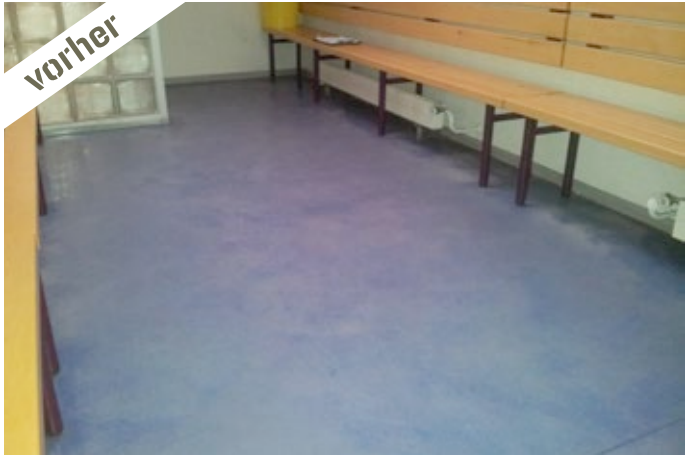
Beispiel: Sporthalle Mühlheim, Umkleideraum
